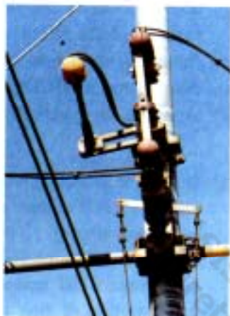
Figura 13: Commutatore in posizione di chiuso
