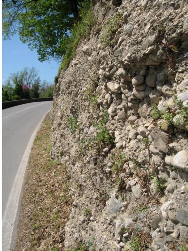
*Figura 18 – Particolare di BPa. I clasti, di dimensione centimetrico-decimetrica, sono ben arrotondati e poligenici.*
