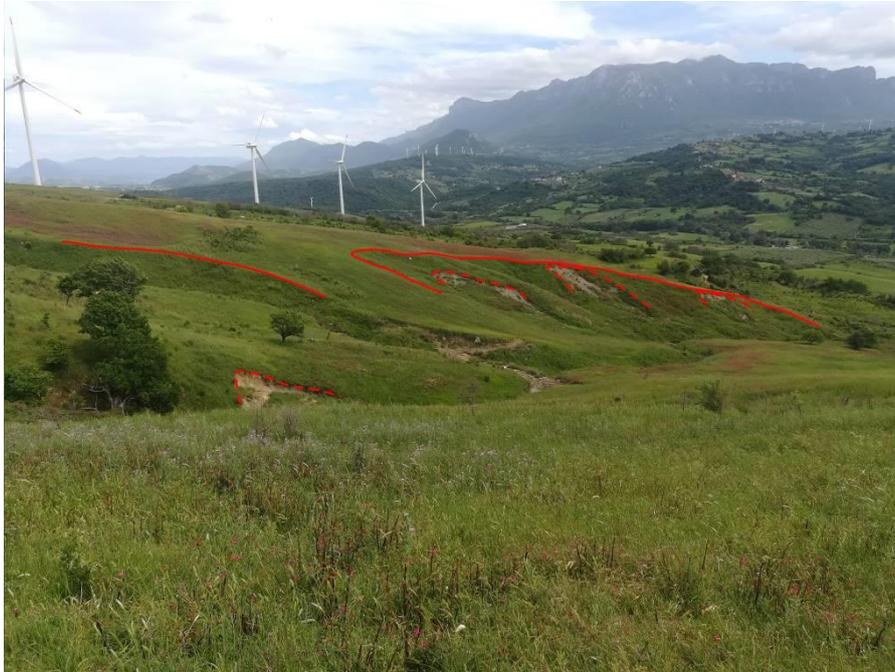
Figura 31 – Dettaglio di movimenti franosi localizzati che vanno a riattivare i depositi in frana evidenziati in Figura 30.
