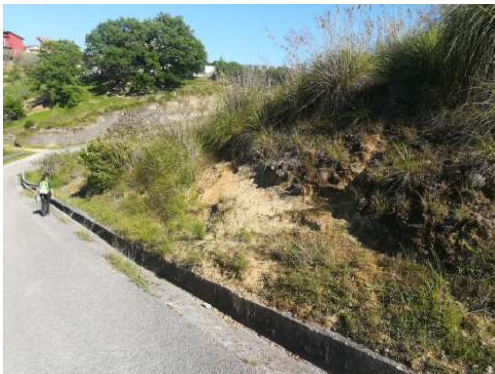
Affioramento di sabbie travertinose lungo la scarpata di monte dela strada.
