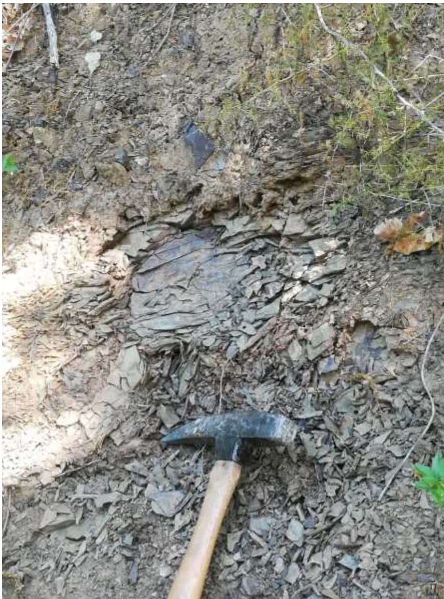
Particolare dell'affioramento, in cui si evidenzia la frattura galestriforme delle argille
