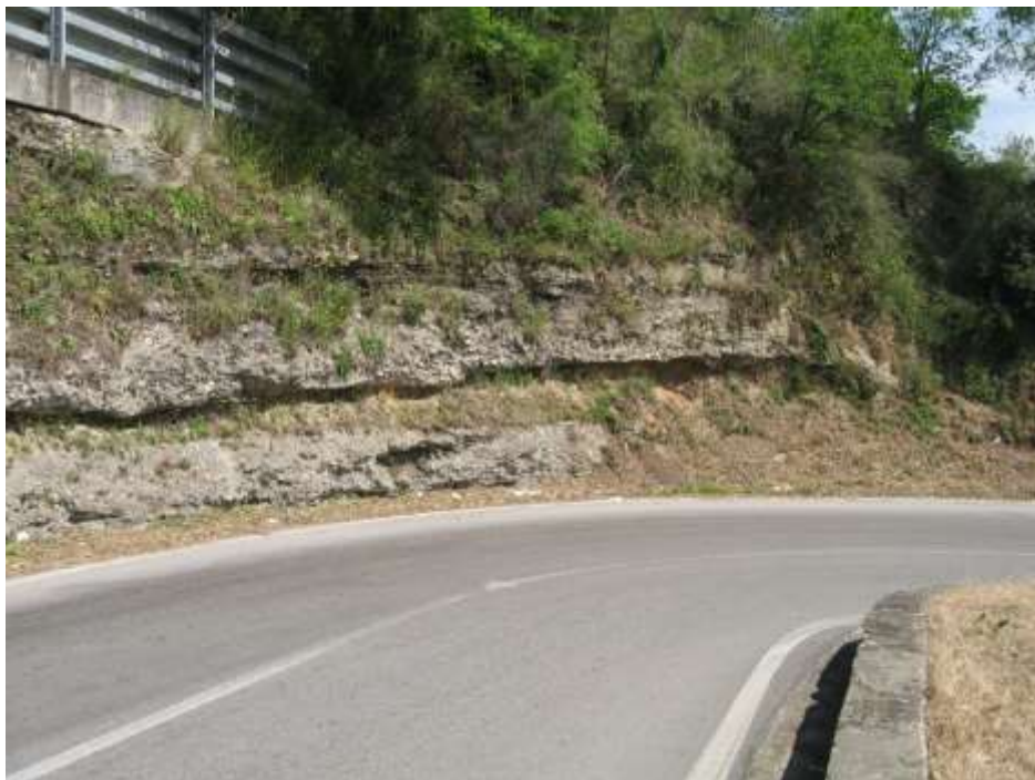
Affioramento di BPa in corrispondenza del tornante sulla Strada Statale 19. Si riconoscono le alternanze di livelli a differente granulometria, con le bancate più grossolane che hanno resistito maggiormente all'erosione.
