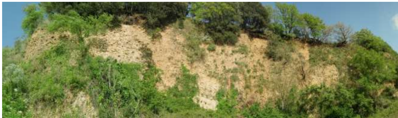
Panoramica della scarpata subverticale di circa 30 m di altezza che costituisce l'affioramento, sulla sinistra idrografica del Fiume Sele. S
