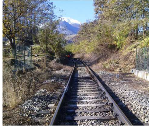
Impianto lubrificazione P.A.L. Italia (Foto: P.A.L. Italia; 2012)
