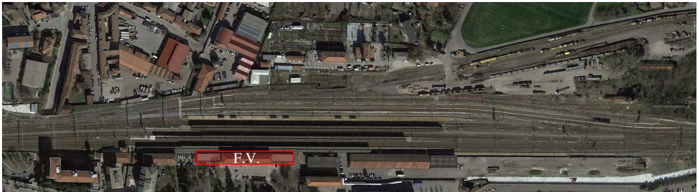
Figura 2 - Stazione di Voghera (Fonte: Google Earth)
