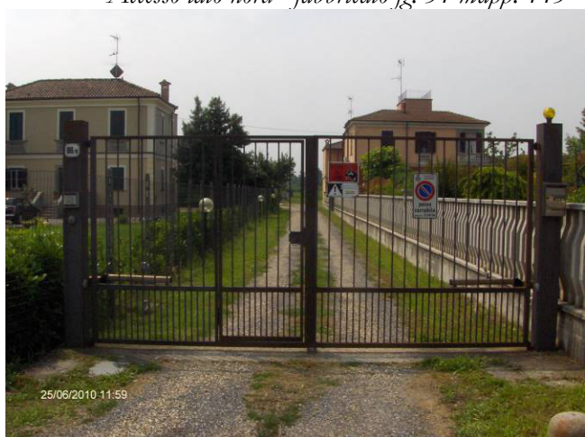
- Accesso lato nord –fabbr. fg. 51 mapp. 312 - 313
