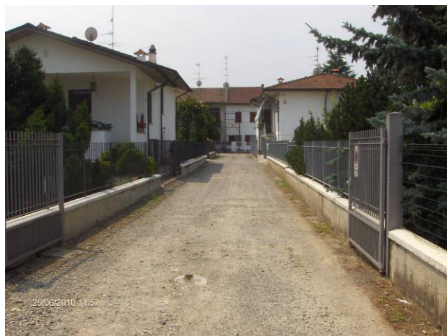
- Accesso lato nord – fabbr. fg. 51 mapp. 240 - 473
