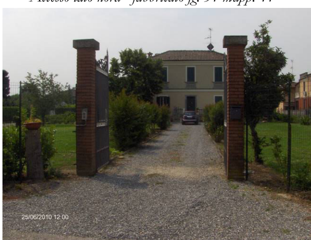
- Accesso lato nord –fabbr. fg. 51 mapp. 113
