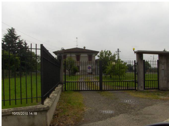
- Accesso lato nord –fabbr. fg. 51 mapp. 140
