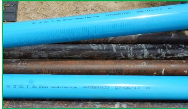
Foto 4.1: Fase installazione piezometro; a destra, particolare tubazione del caso specifico (S2 - Ø 3").
