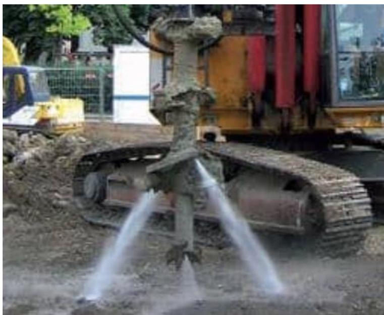
*Figura 3: Particolare pulizia ugelli in wet deep mixing*
