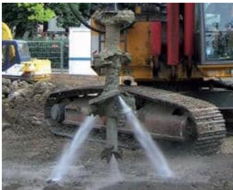
Figura 4: Particolare pulizia ugelli in wet deep mixing
