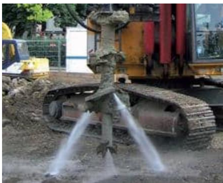
Figura 7: Particolare pulizia ugelli in wet deep mixing
