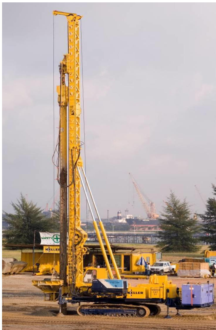
Figura 9: Tipica attrezzatura per colonne di ghiaia con immissione della ghiaia a secco a fondo foro
