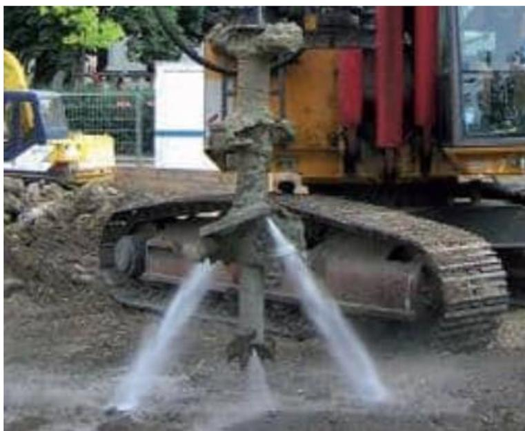
*Figura 2: Particolare pulizia ugelli in wet deep mixing*
