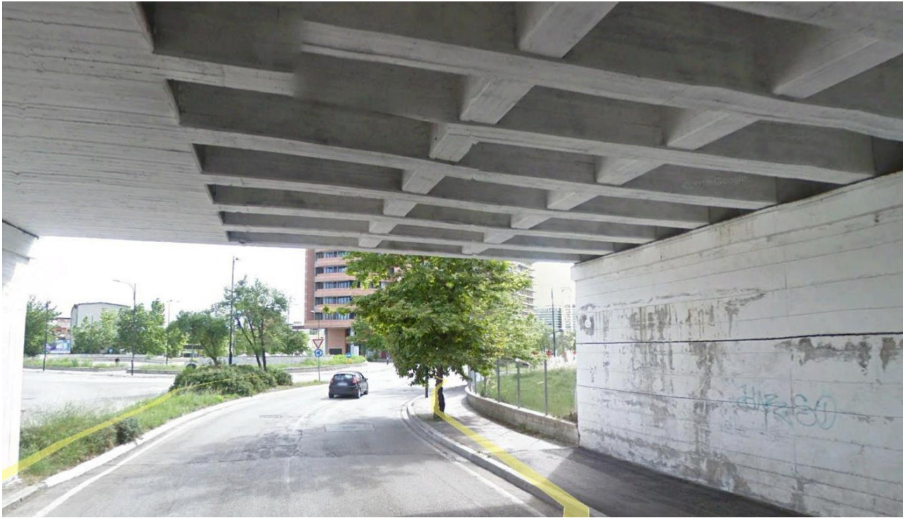
Fig. 5 – VI01 – Ponte su Via Sparto – Lato imbocco Est
