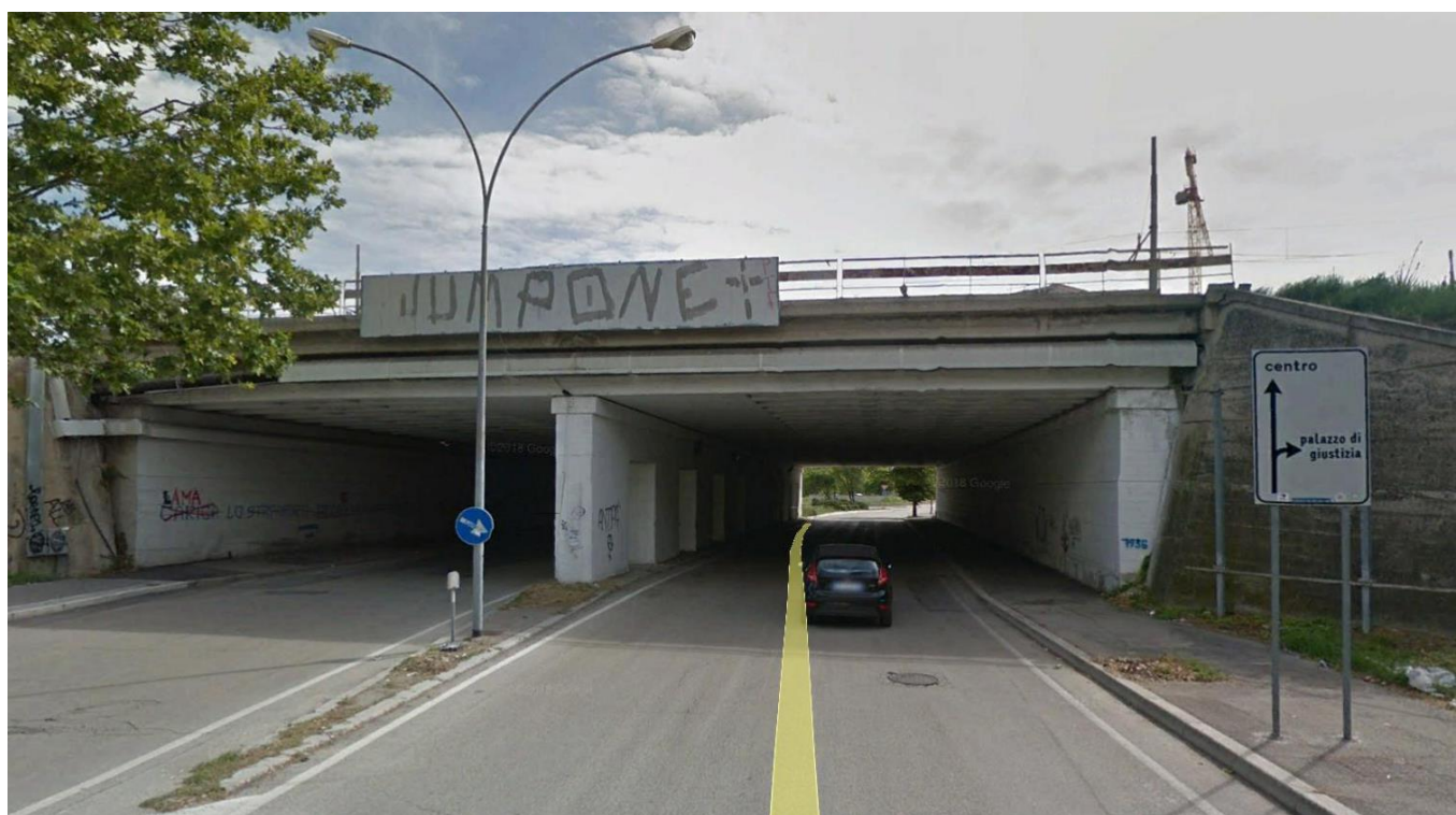
Fig. 2 – VI01 – Ponte su Via Sparto – Lato imbocco Ovest
