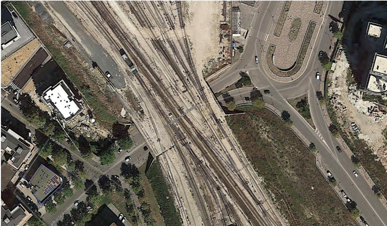
Fig. 11 – VI01 – Ponte su Via Sparto – Inquadramento planimetrico al 22.09.2015
