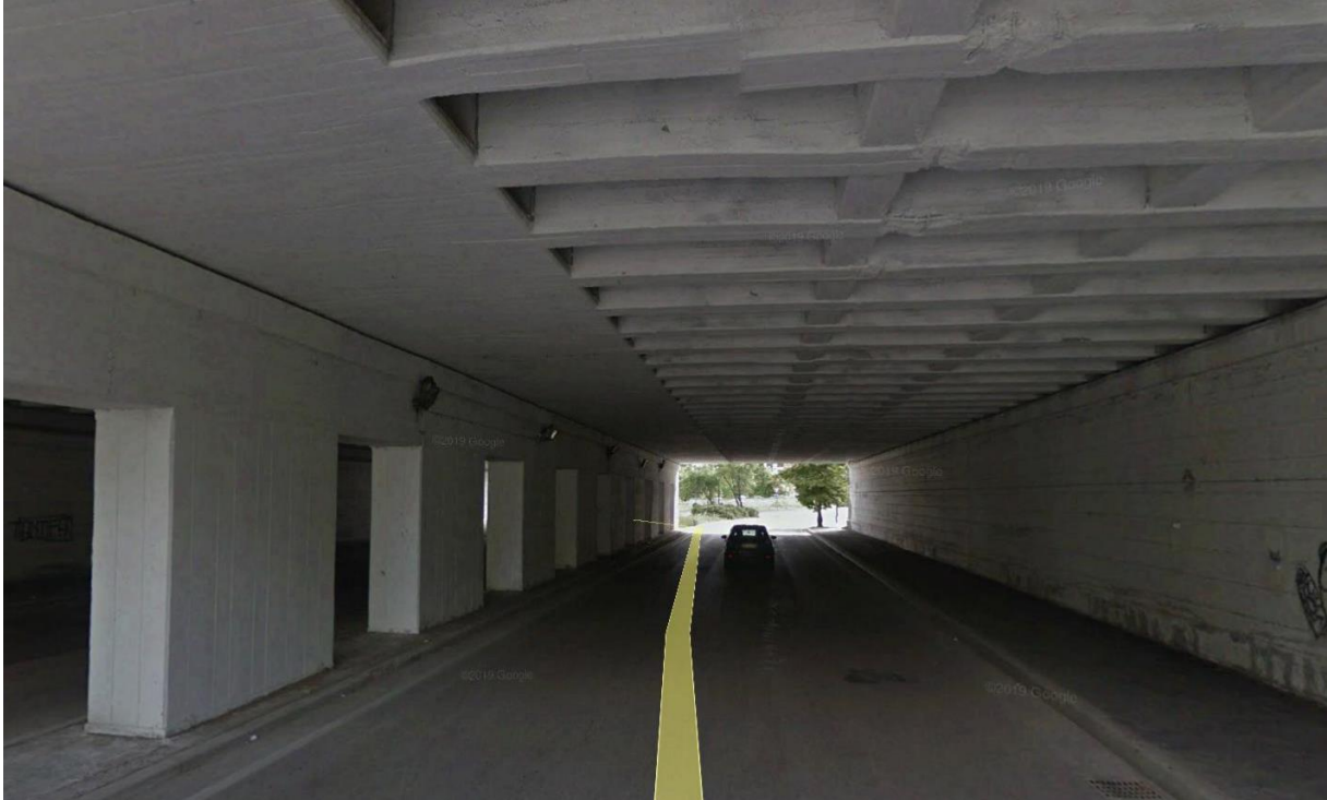
Fig. 3 – VI01 – Ponte su Via Sparto – Interno ponte
