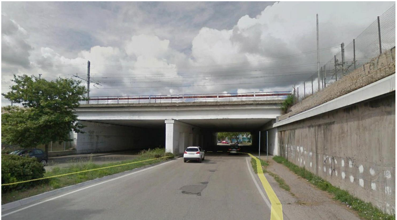
Fig. 6 – VI01 – Ponte su Via Sparto – Lato imbocco Est
