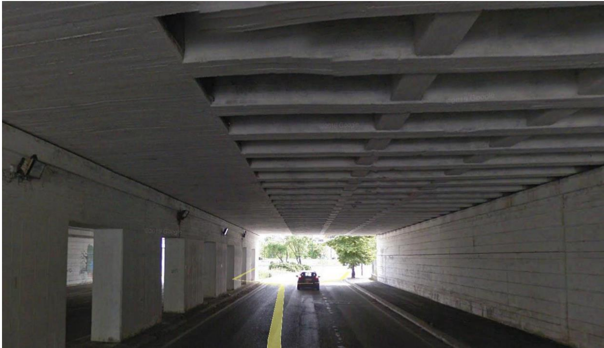
Fig. 4 – VI01 – Ponte su Via Sparto – Interno ponte
