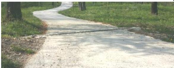
Pavimentazione drenante realizzata con stabilizzanti naturali terreno
